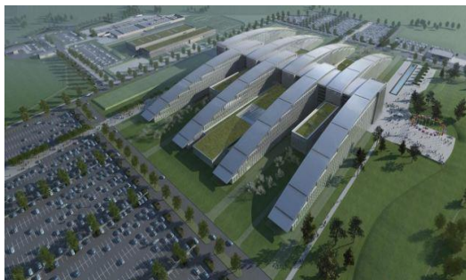
Fig. 11. Noul sediu NATO din Bruxelles, vedere de sus, design semnat de Skidmore, Owings și Merrill 2014. Sursă: Skidmore, Owings and Merrill
